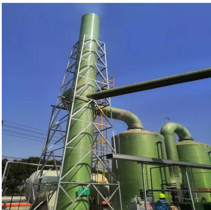
图 4.1-6 预处理工序酸喷淋+碱喷淋系统
